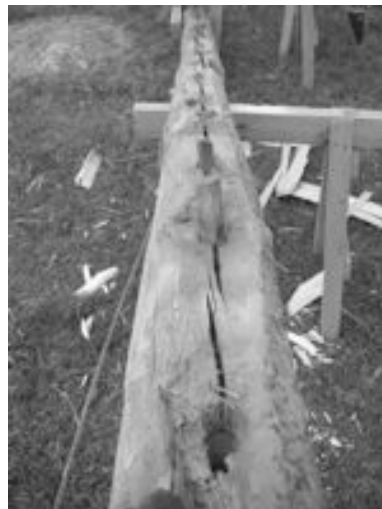
Bild t.v. Planritning med röd pil som markerar timmer huggt till mötes, se foto sid 23. Bild t.h. förbrukad taksparre från västra längan. Observera hur dubben nästan spräckt sparren.
