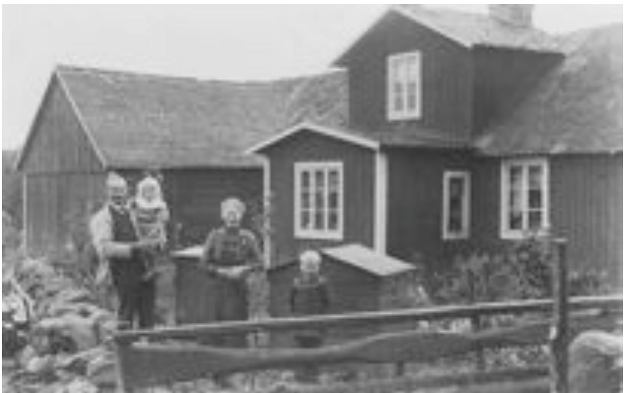
Byggmästare Olof Jönsson håller Evert. Därnäst Everts mor Matilda Mårtensson och storebror Gösta. Huset är inte byggt av Olof. Lagg märke till stockarna i nedre vänstra hörnet, de kan var a bilade av Olof. Staketet i förgrunden har överst en bilad slana och där under en sågad utskottsbräda. Foto från ca 1920, i privat ägo.
