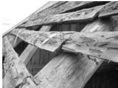
Bild t.v. Kluvet hanaband i arrendatorbostaden. Bild mitt. Arrendatorbostadens södra sida under omtäckning. Bild t.h. närbild på arrendebostadens kluvna läkt.
