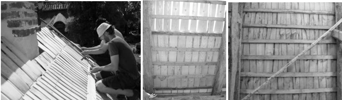
Bild t.v. Kursdeltagare lägger sticketak, det översta lagret är förskalning. Läggningsen sker från vänster till höger, de är nästan klara med varvet. Bild mitt. Samma takfall sett inifrån. Observera att förskalningsstickorna ligger med ca 1 cm mellanrum. Bild t.h. Förskalning i Hjärsås där stickorna har överlapp.
