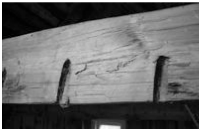
Bild t.v. Kluvet hanaband i arrendatorbostaden. Bild mitt. Arrendatorbostadens södra sida under omtäckning. Bild t.h. närbild på arrendebostadens kluvna läkt.
