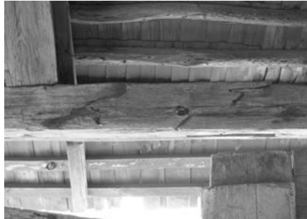
Bild t.v. Tjocka spån fotograferade utifrån. Bild t.h. Lejden syns i mitten av bilden. Under lejden syns de sågade spånen som ligger bredvid varandra. Ovanför lejden syns de hyvlade spånen som ligger omlott. Sticketaket är lagt från vänster mot höger.
