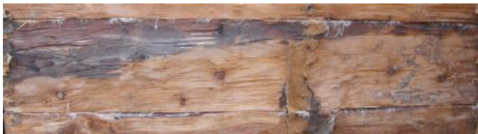
Bild t.v. Tre danska högerhänta timmermän med olika höjd på sina bockar. Lägga märke till att de bilar om skogshugget timmer (efter Christensen 1946:67). Bild t.h. Timmer som bilats om efter torkning. Bilden tagen på timmerhus från Ljungbyholm, Småland. Under tecknad var med och plockade ner huset och återuppförde det på Hanö i Blekinge.
