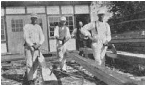
Bild t.v. Tre danska högerhänta timmermän med olika höjd på sina bockar. Lägga märke till att de bilar om skogshugget timmer (efter Christensen 1946:67). Bild t.h. Timmer som bilats om efter torkning. Bilden tagen på timmerhus från Ljungbyholm, Småland. Under tecknad var med och plockade ner huset och återuppförde det på Hanö i Blekinge.
