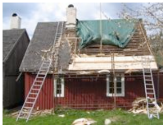
Bild t.v. Kluvet hanaband i arrendatorbostaden. Bild mitt. Arrendatorbostadens södra sida under omtäckning. Bild t.h. närbild på arrendebostadens kluvna läkt.
