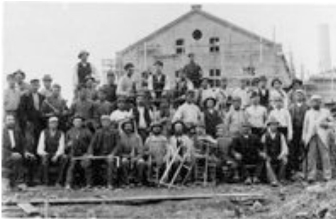
Byggarbetsplats i Skåne kring sekelskiftet samt detalj av bila efter (Palmqvist 1996:326). På första raden sitter tre timmermän hållande yxa, timmermansvinkel och bredbila. Mannen med bredbila har en högerbila han håller även högerhanden närmast bilan vilket är brukligt. Skaftet är relativt kort vilket indikerar att stocken legat på höga bockar. Lägga märke till alla ställningssågar och avsaknaden av fogsvarsar.
